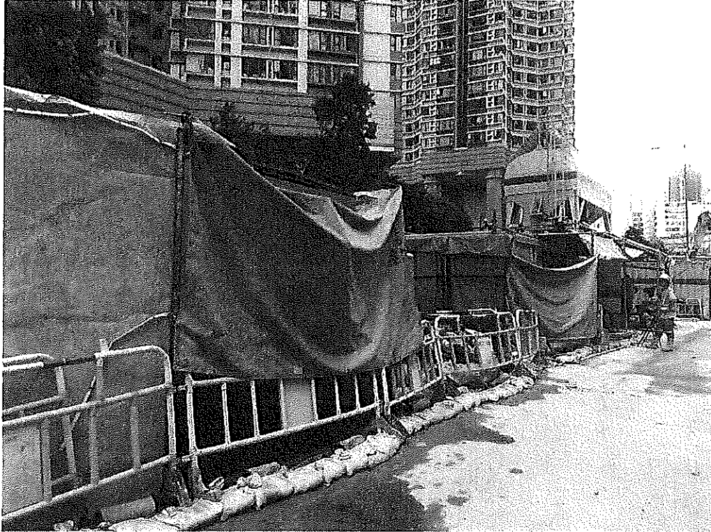
附圖一：海泓道工地設置隔音布
